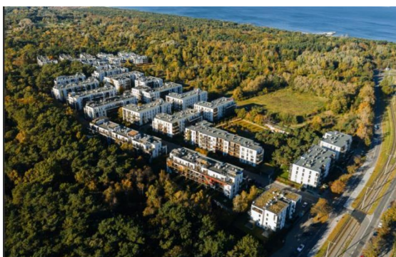
fot. widok na osiedle z lotu ptaka
